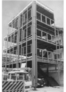
工事中の新ビル
